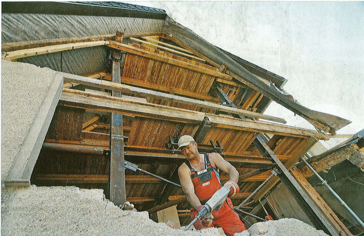
Alexander Liebe baut die Fassade des schwer beschädigten Hauses zurück. Das Dachgeschoss wird von Stahlträger gehalten. Die die Doppelhaushälfte, die seit anderthalb Jahren baupolizeilich gesperrt war, wird wieder aufgebaut.
